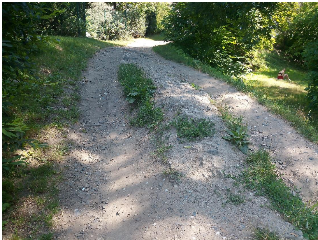
Betonový blok - pohled do svahu
